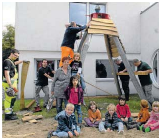
Mitarbeiter des Entsorgungszentrums bauten für die Kinder des Arche-Noah-Kindergartens ein Spielhaus mit zwei Ebenen.
